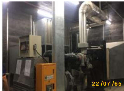
รูปที่ 2.19 ห้องเครื่องกำเนิดไฟฟ้าสำรอง
